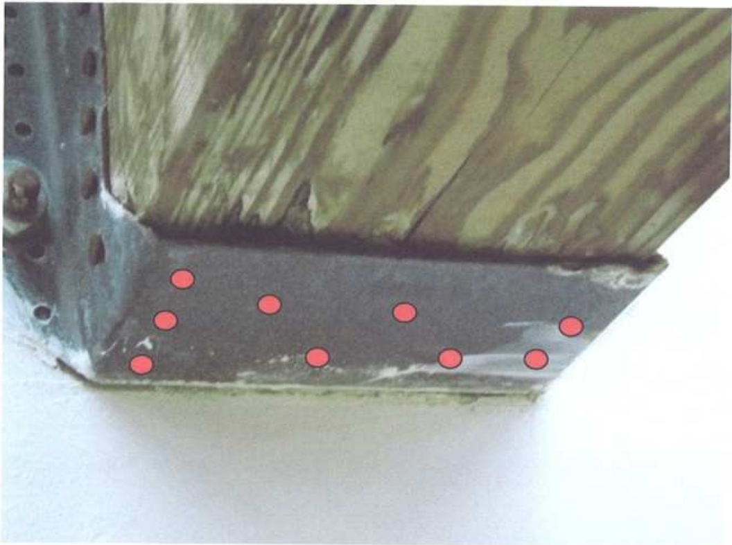
Fot. 1. Rozmieszczenie otworów wentylacyjnych w podporach belek.
